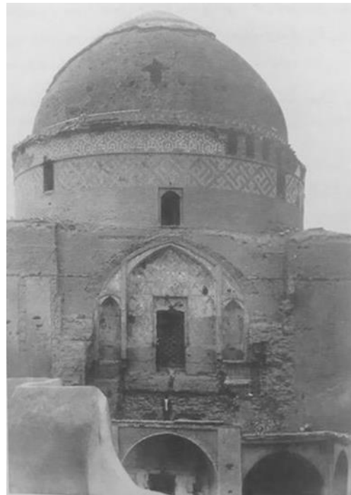
(تصویر ۵) سمت شمال مدرسه رکنیه در ابتدای قرن ۱۴ هجری و قبل از خاکریزی‌ها و تصرفات اخیر (۱۲)
